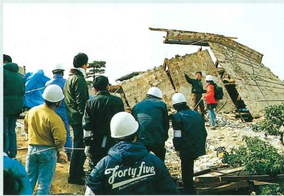
●全壊したお寺の解体作業をするボランティア。
